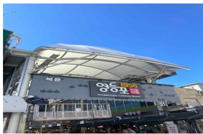
영등포전통시장 북문 가림막 설치
