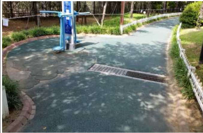
영등포공원 보수정비 공사전
