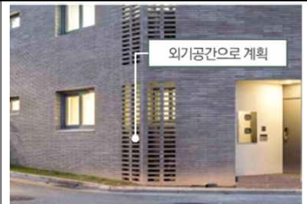
건물 내부 일체화하여 실외기 설치
