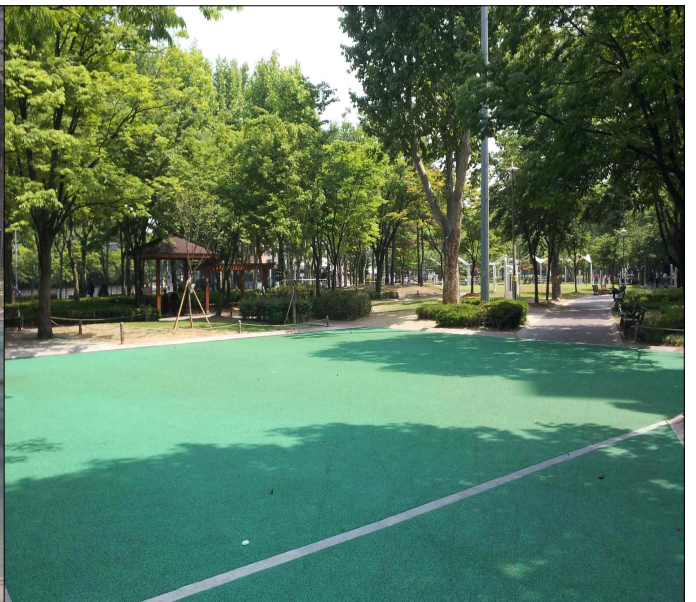
문래공원 체조공간 바닥 정비 후
