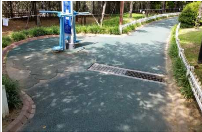
영등포공원 보수정비 공사전
