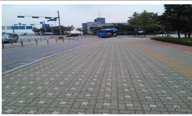
띠녹지 조성 공사전
