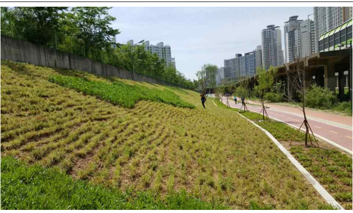
도림천 제방사면 조성(후)
