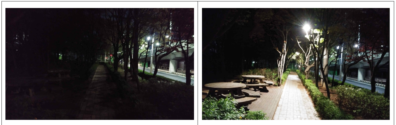
대방천 녹지내 산책로 조명등 설치 사업
