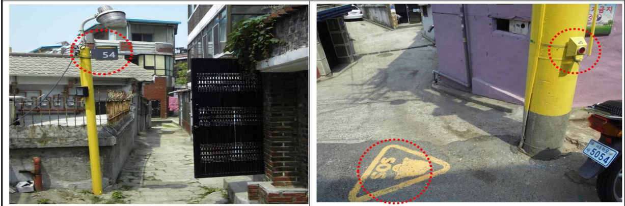
여성안전 가로등 번호와 비상벨 설치 예시도
