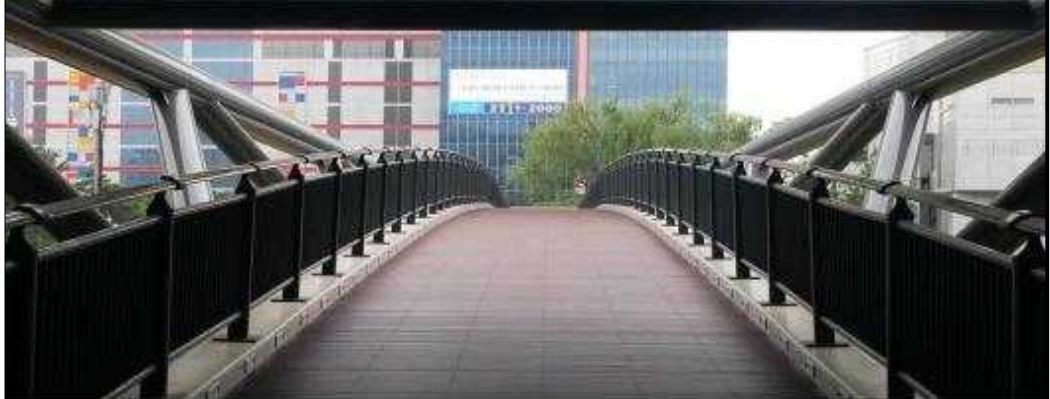
육교 상부 전경
