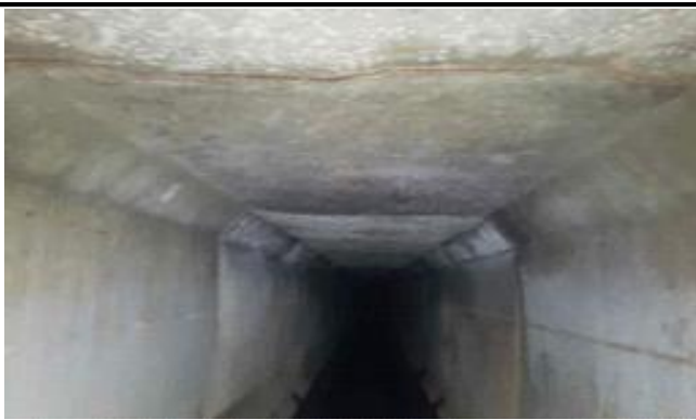
악취저감시설 설치 전
