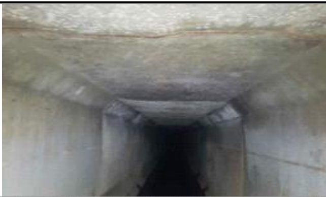
악취저감시설 설치 전
