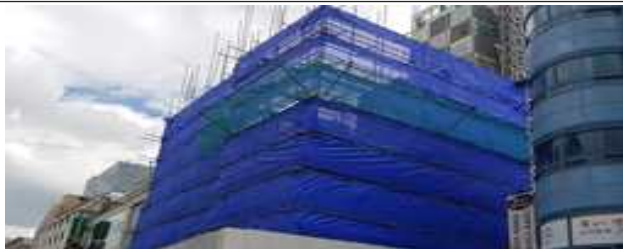
시스템비계 + 방진막 설치 공사장 예시
