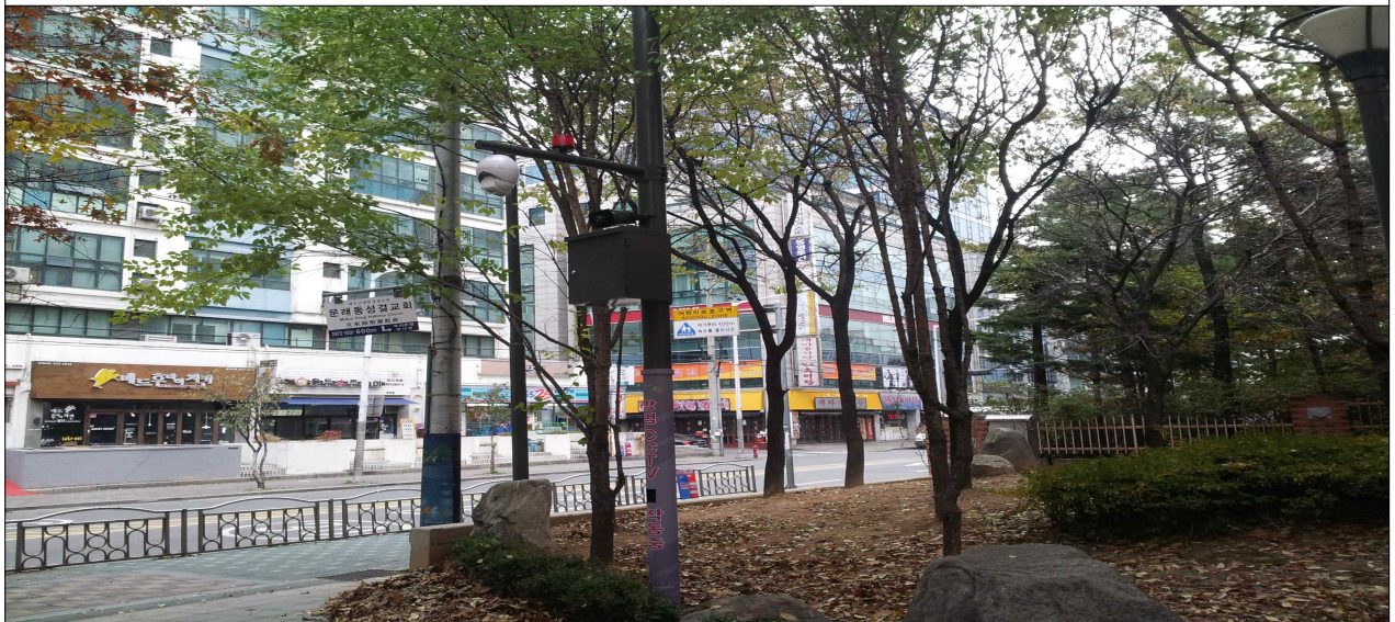
CCTV 설치 후
