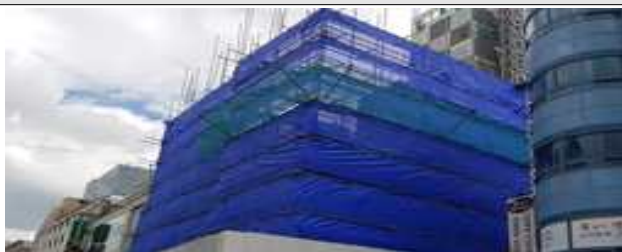
시스템비계 + 방진막 설치 공사장 예시
