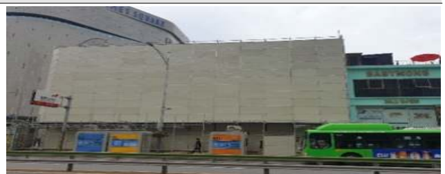
건축선 지정 대도로변 해체현장 소음저감형 판넬 설치 예시
