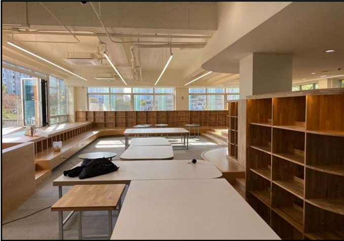
대림정보문화도서관 리모델링('20.11월 예정)
